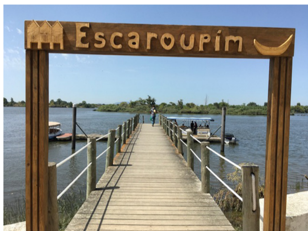
Cais de madeira em Escaroupim
