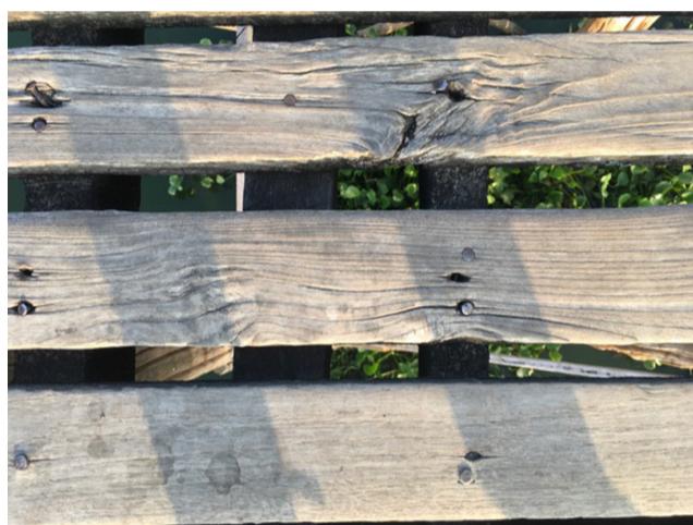
A madeira de teca com 200 anos na plataforma da ponte mais comprida do mundo em madeira
