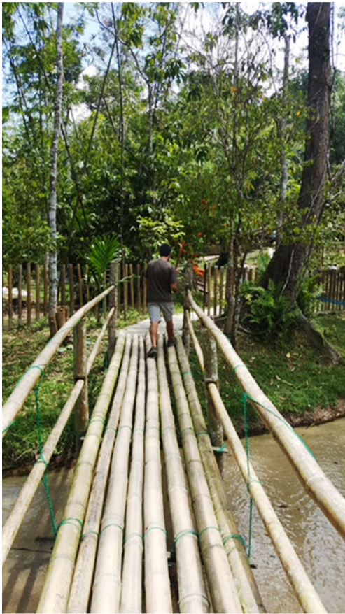
Passagem feita com bambu
