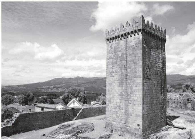
FIG. 1. Castelo de Melgaço, Torre de Menagem.
