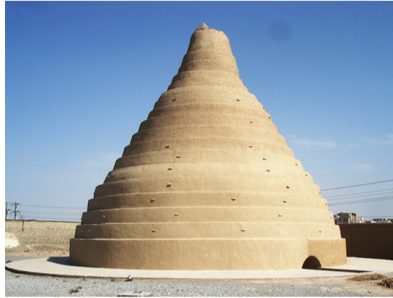
Depósito de gelo, em Abarkuh
