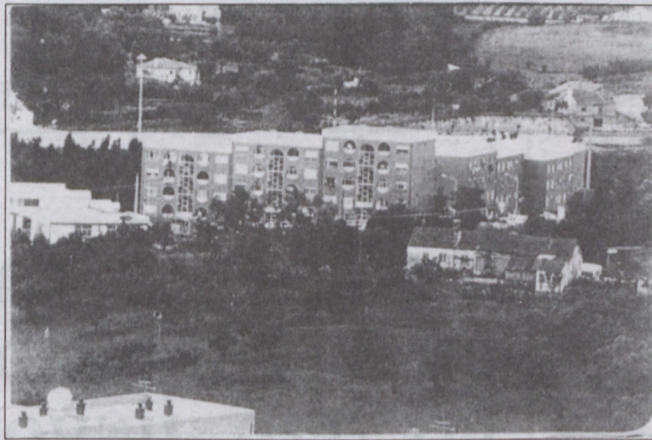
1ª Fase de Construção - 90 Fogos - Santarém
