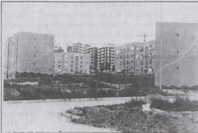
2ª Fase de Construção - 104 Fogos - Santarém
