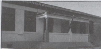
Vista parcial da Escola
