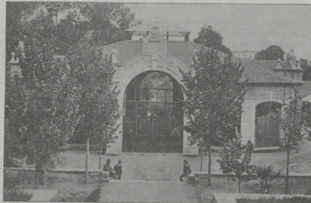
Peso - Pavilhão das Águas
