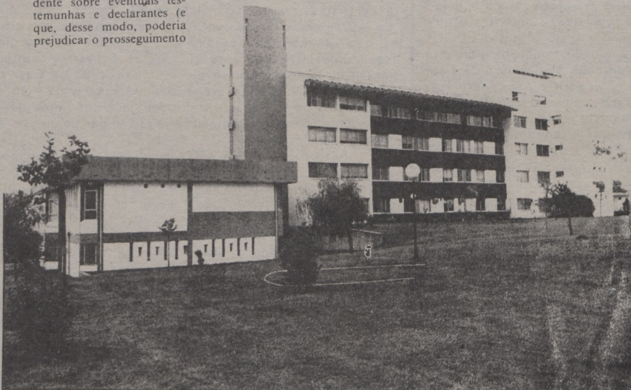
Universidade de Aveiro: obras na cantina originaram algumas das irregularidades noticiadas pelo EXPRESSO
