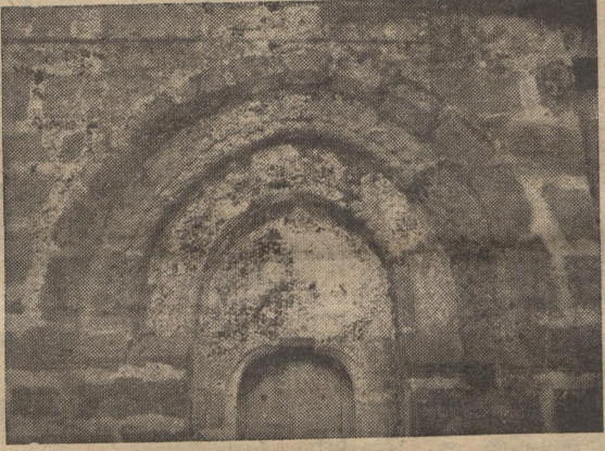
Parte superior da porta lateral da Igreja de Lamas (Foto do Sr. Dr. J. Fronteira.)
