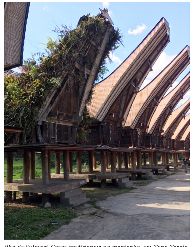
Ilha de Sulawesi-Casas tradicionais na montanha, em Tana Toraja, construídas em bambú
