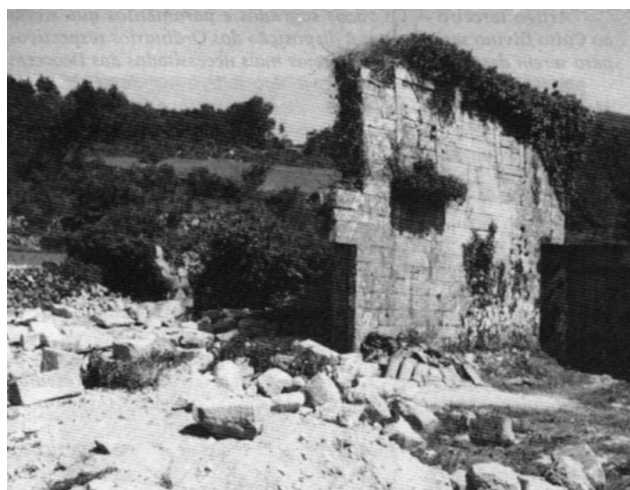
Foto 1 - Fachada poente do conjunto conventual.
