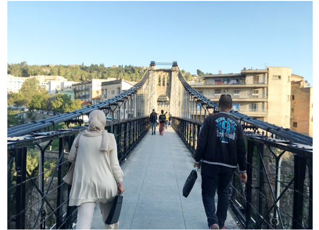
Tantas pontes diferentes em tamanho e técnicas de construção!
