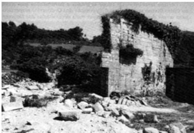
Fig. 2 - Restos do alçado poente - lado sul, por volta de 1960.
