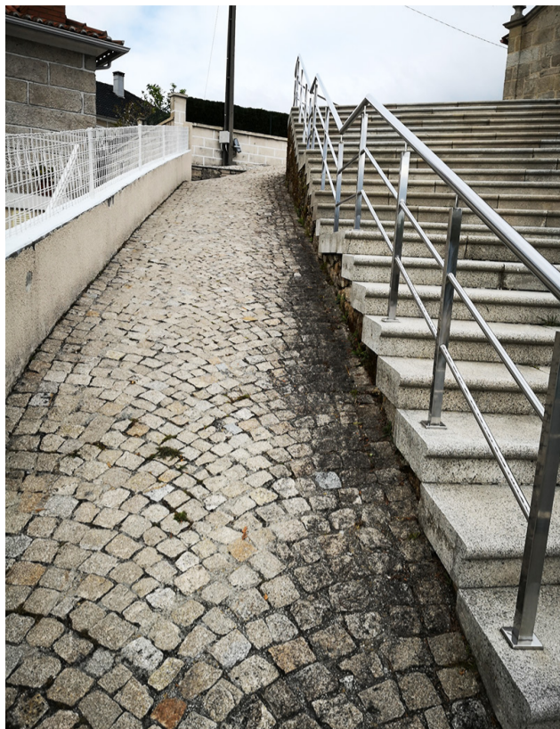
Grade das escadas - lado esquerdo
