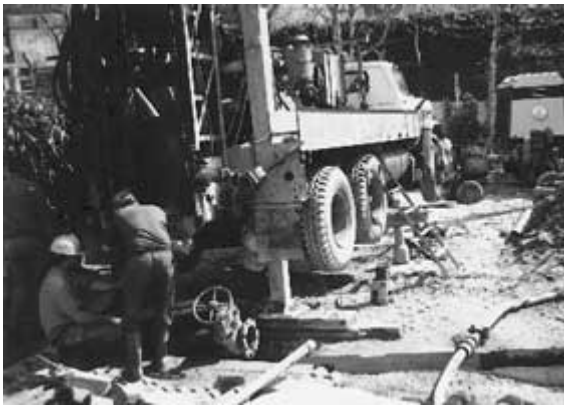
Foto 1 - Equipamento de perfuração
