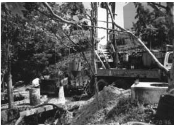
Foto 4 - Injeção de seixo calibrado
