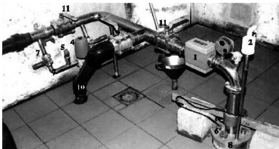
Figura 4 - Sistema de monitorização de uma captação incluindo as sondas de pH, temperatura, condutividade, filtro de ar e medidor de caudal. Legenda: 1-Caudalímetro; 2-Filtro de ar bacteriológico; 3-Sonda de temperatura; 4-Sonda de condutividade; 5-Sonda de pH; 6-Sonda de nível; 7-"By-pass"; 8-Cabeça do furo; 9-Manómetro de pressão; 10-Saída de esgoto; 11-Válvula.
