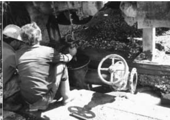
Foto 2 - Descida da coluna 10", com válvula de controlo de artesanismo
