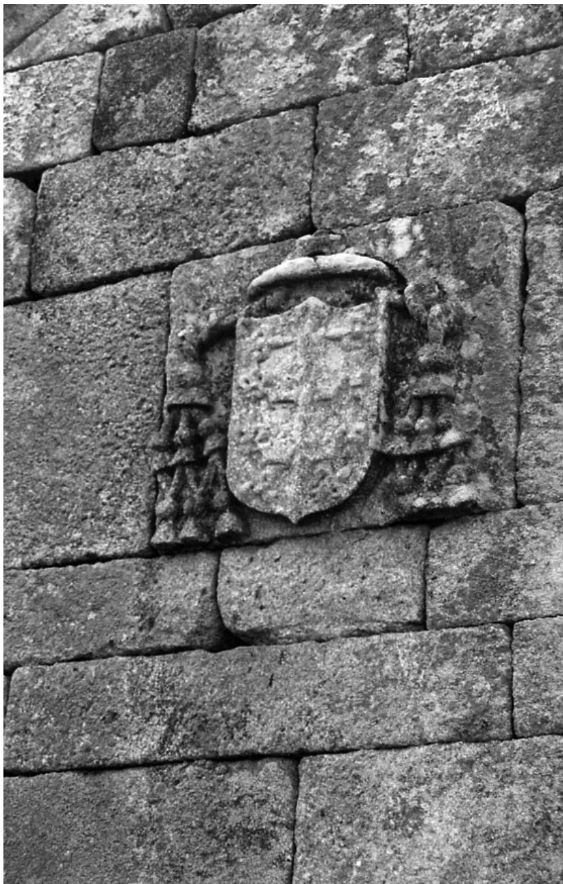
Igreja N a Sra. de Guadalupe - Pedra de armas colocada na parede fundeira da capela-mor
