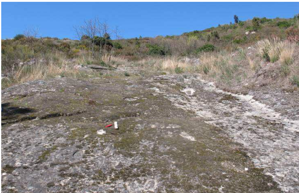
Figura 175: Fraga das Passadas antes dos trabalhos de limpeza. Do lado direito pode observar-se a parte do afloramento que foi caminho carreteiro.
