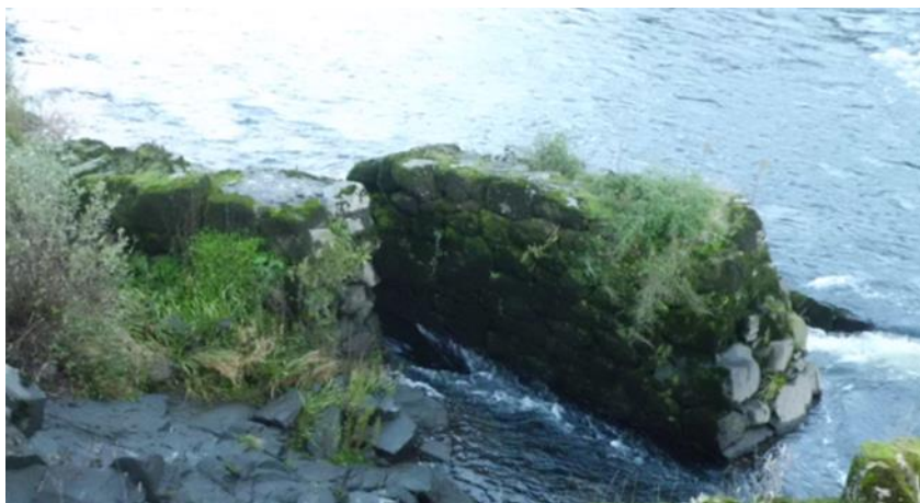
Figura 18 - Um "poio" ou "piauí" serve de travamento a outro.
