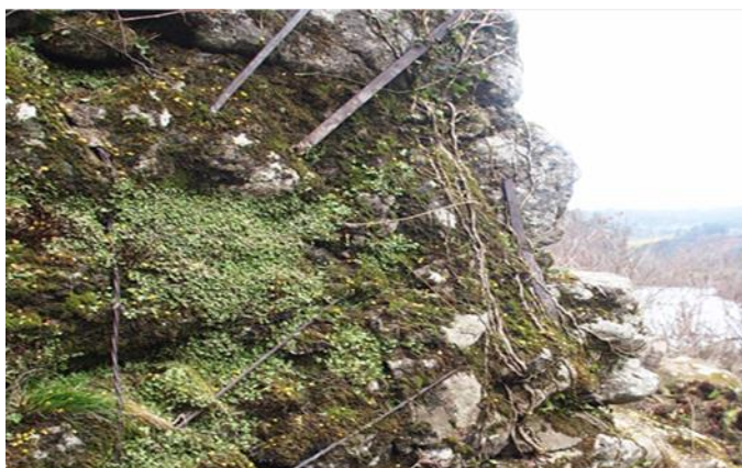
Figura 36 - Grampos de ferro que reforçam a segurança das rochas.
