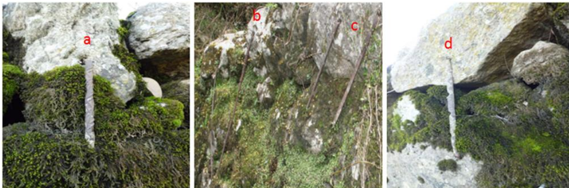
Figura 37 - Grampos de ferro que suportam a estrutura das pesqueiras.
